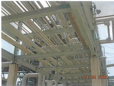
ภาพที่ 2-23 การติดตั้งท่อขนส่งบนฐานรองรับเหนือพื้น
