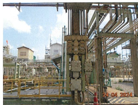
ภาพที่ 2-21 ระบบไฟฟ้าแบบ Explosion Proof
