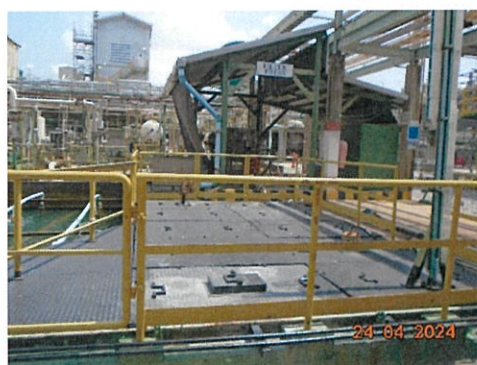
ภาพที่ 2-7 บ่อ Oil-Waste Separator
