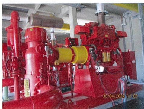
ภาพที่ 2-34 Fire Pump เป็น Vertical Pump บริเวณ Fire Pond
