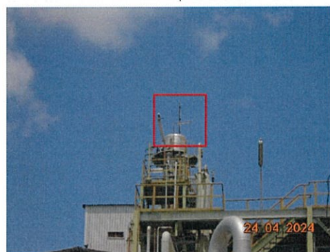
ภาพที่ 2-22 ระบบป้องกันฟ้าผ่าและสายดิน
